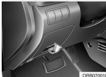
Панель предохранителей на приборной панели
